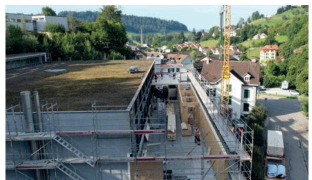
Elba-Halle: Die Aufstockung in Form einer Holzkonstruktion wird aufgerichtet.
