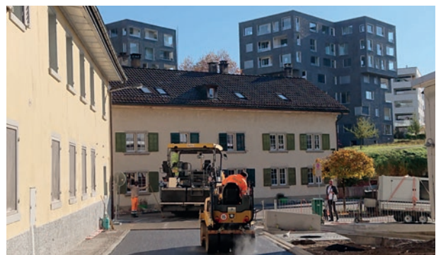
Belagseinbau inmitten des historischen Ensembles. Im Hintergrund die urbanen Bleiche-Wohnhäuser.
