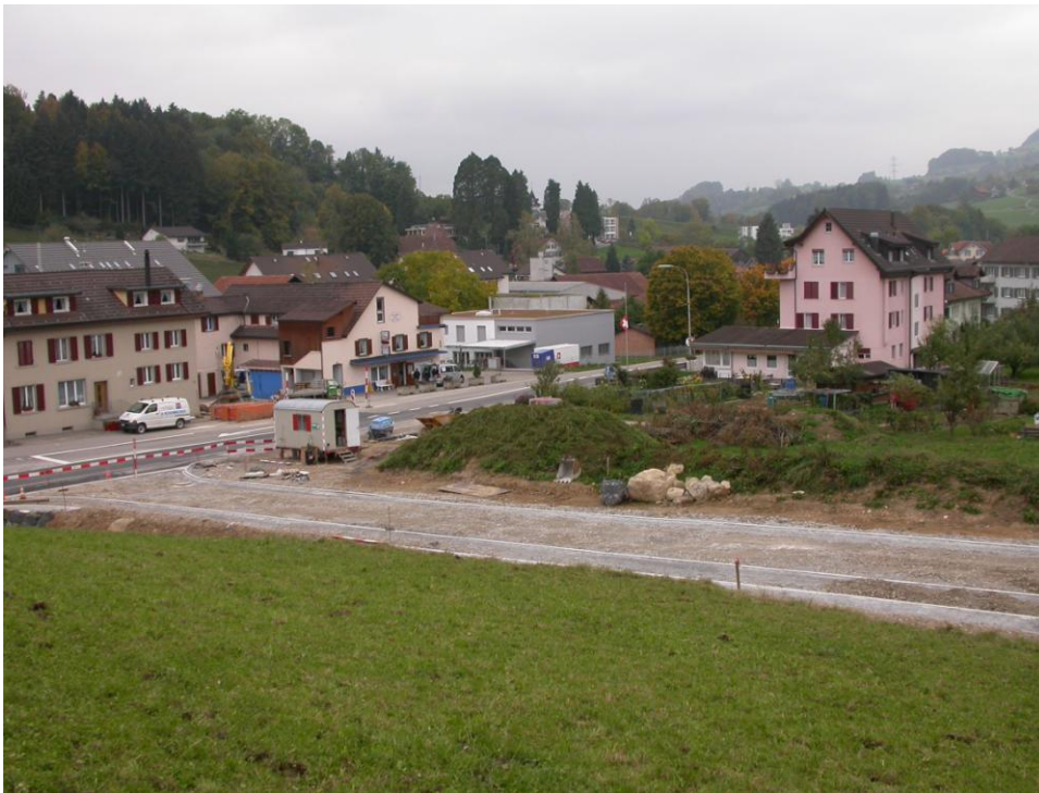
Foto: Erschliessung des Quartierplangebietes Hinternord-Brugglen
