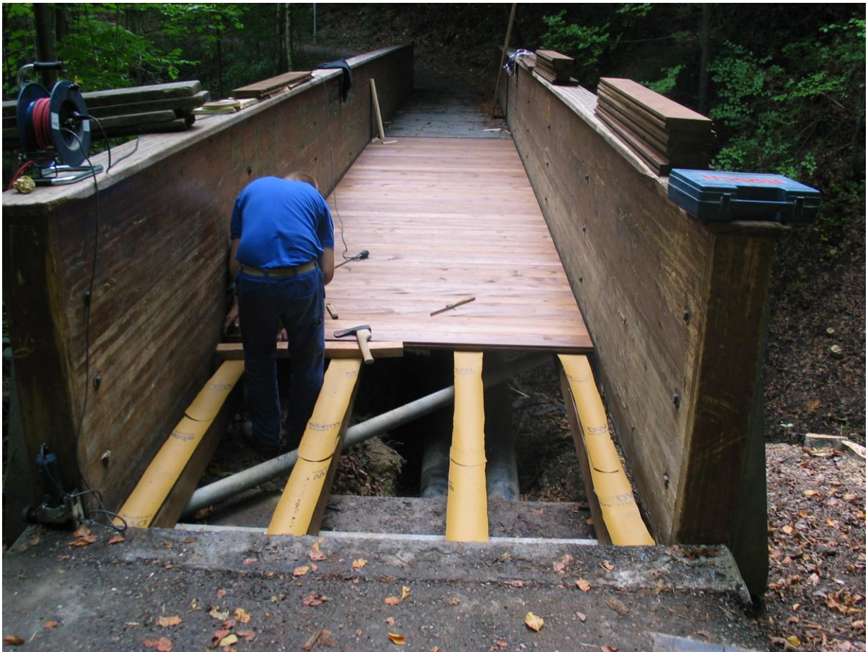
Foto: Sanierung der Binzholzbrücke
