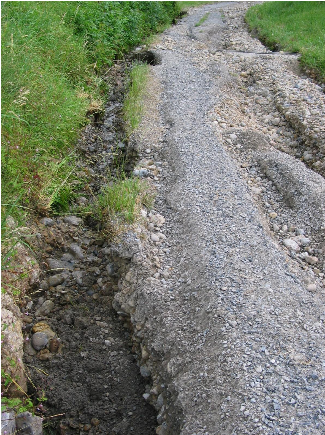
Foto: Schaden an der Alten Raaderstrasse
