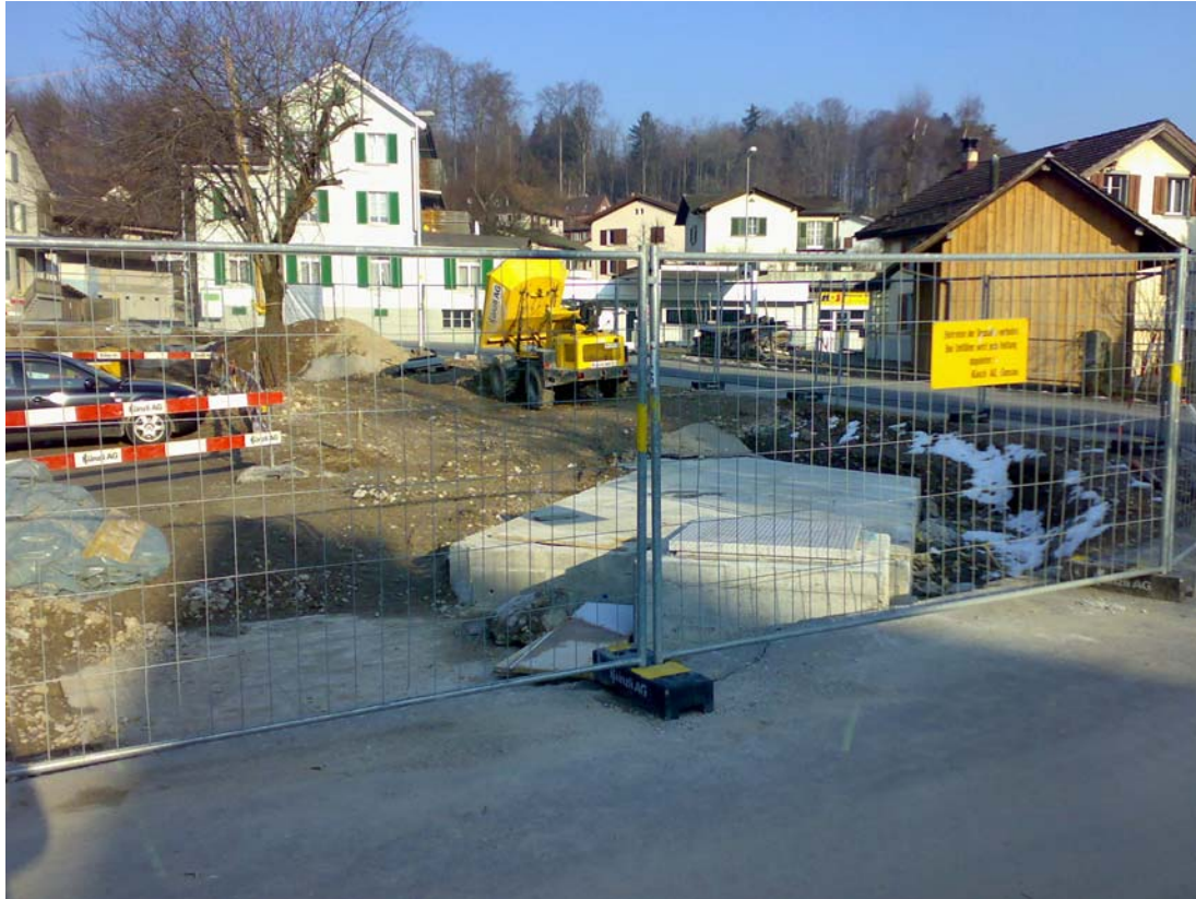
Bild: Neu erstelltes Retentionsbecken
