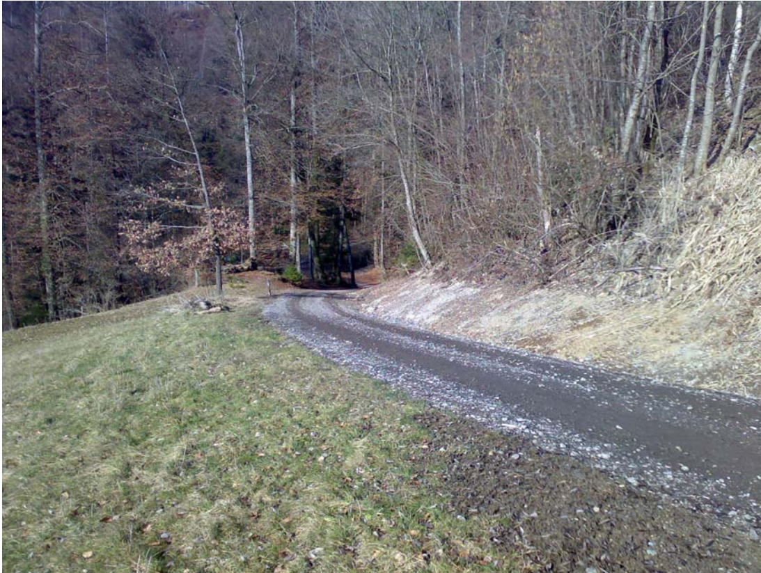
Foto: Töbelstrasse, saniert im Kaltrecyclingverfahren
