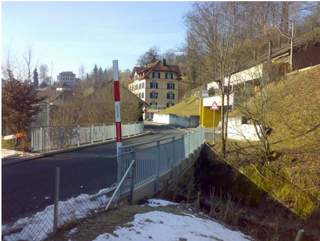
Foto: Brücken- und Fahrbahnsanierung Werkstrasse / Jonabrücke
