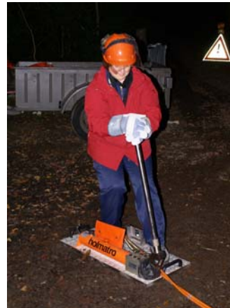
Instruktion an der Hydraulikpumpe
