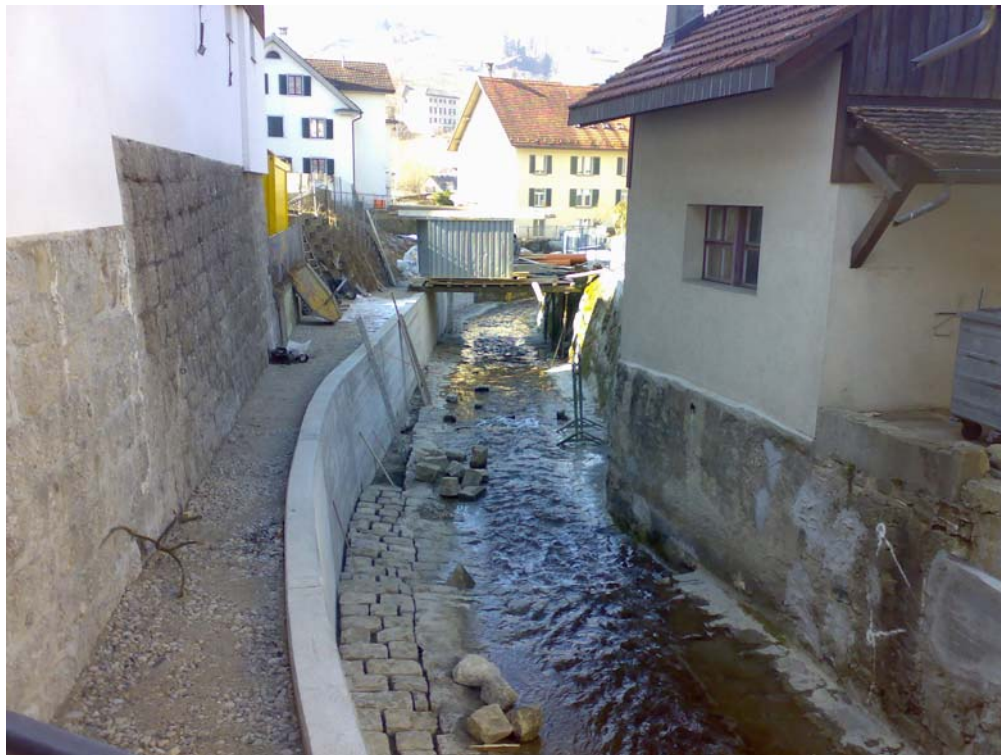
Foto: Schmittenbach mit neuer Ufermauer
