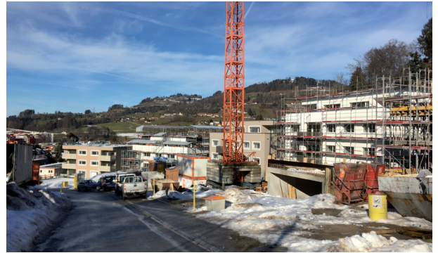
Momentaufnahme des Baufortschritts bei der «Grossüberbauung» Ulmenstrasse.
