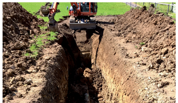
Ersatz von 220 m Schmutzwasserleitung am Asylweg (Jonastrasse bis Ferchacherstrasse).
