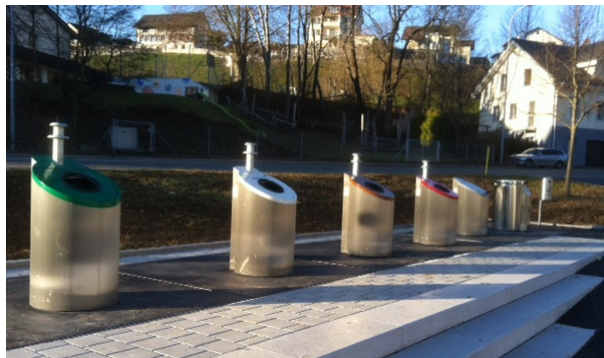
Die Unterflursammelstelle an der Mürtschenstrasse sieht sauber und aufgeräumt aus.
