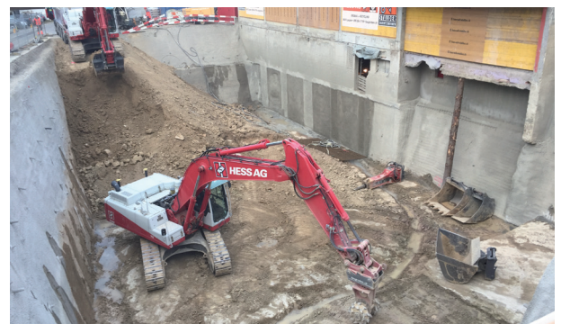
Riesige Mengen an Aushubmaterial wurden aus dem Boden vor dem Hallenbad gebaggert und abtransportiert.
