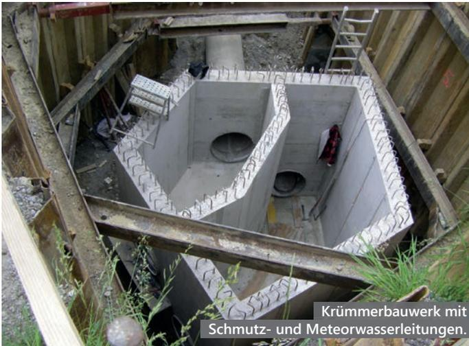
Krümmerbauwerk mit Schmutz- und Meteorwasserleitungen.
