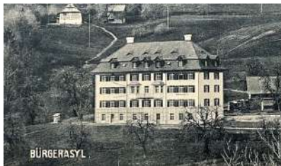
Dreigeschossiges Kerngebäude auf talseitig eingeschossigem Sockelgeschoss mit Walmdach
