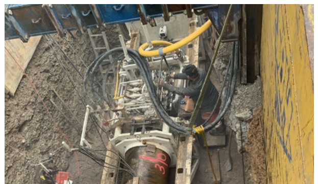
Bohrgerät in der 5 m tiefen Grube beim Bauprojekt Erneuerung Abwasserleitung Ring-/Schützenstrasse.
