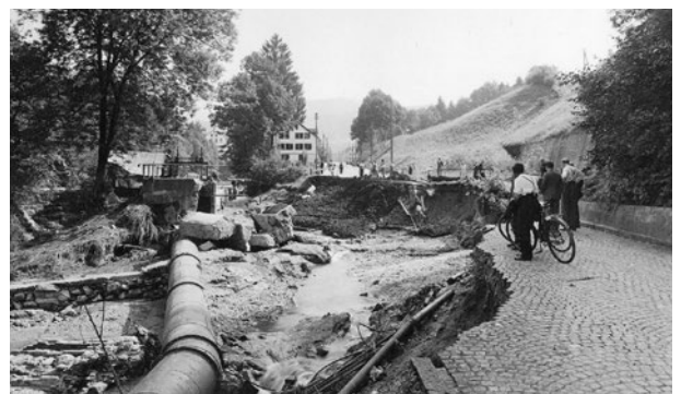
Hochwasser 1939 - Extremereignis mit 107 mm/h Hauptniederschlag. Im Bild die gepflästerte Rütistrasse.
