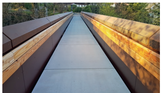
Die analog der Binzholzbrücke sanierte Feisterbachbrücke bietet wieder einen sicheren Übergang.
