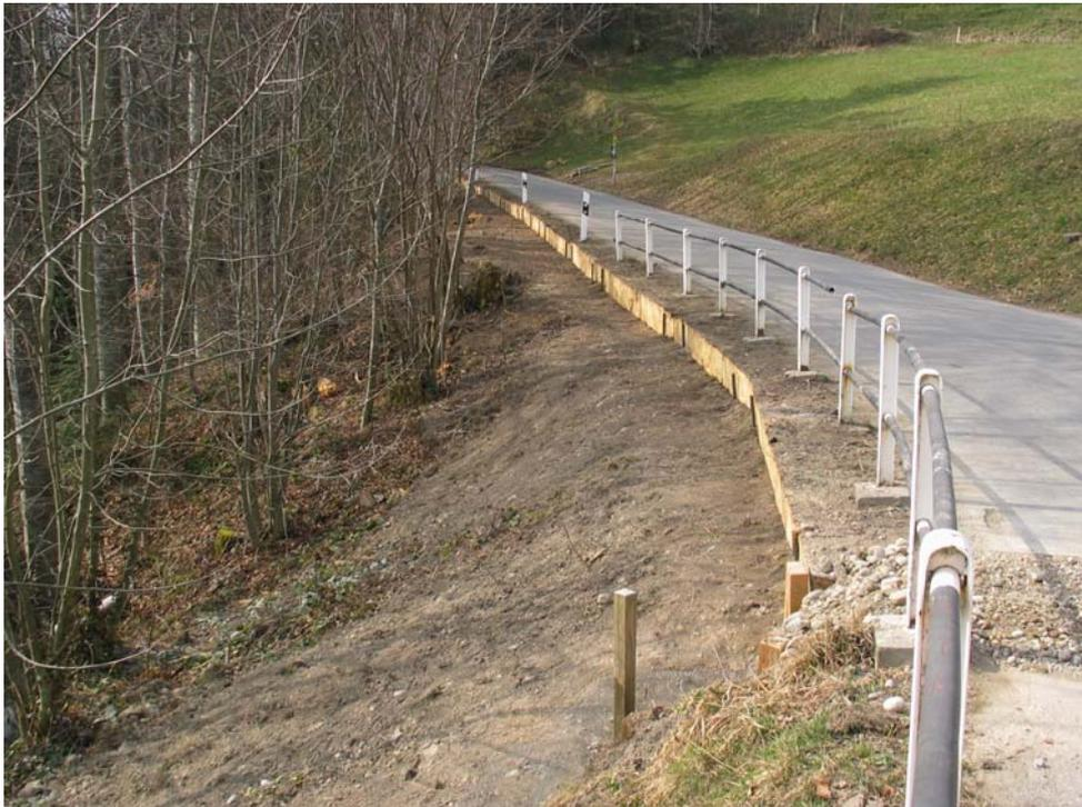
Foto: Froschleitwerk mit Durchlass an der Raaderstrasse
