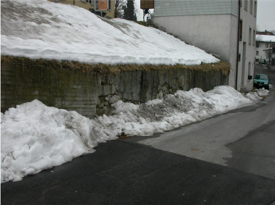
Foto: Defekte Stützmauer an der Stuckstrasse
