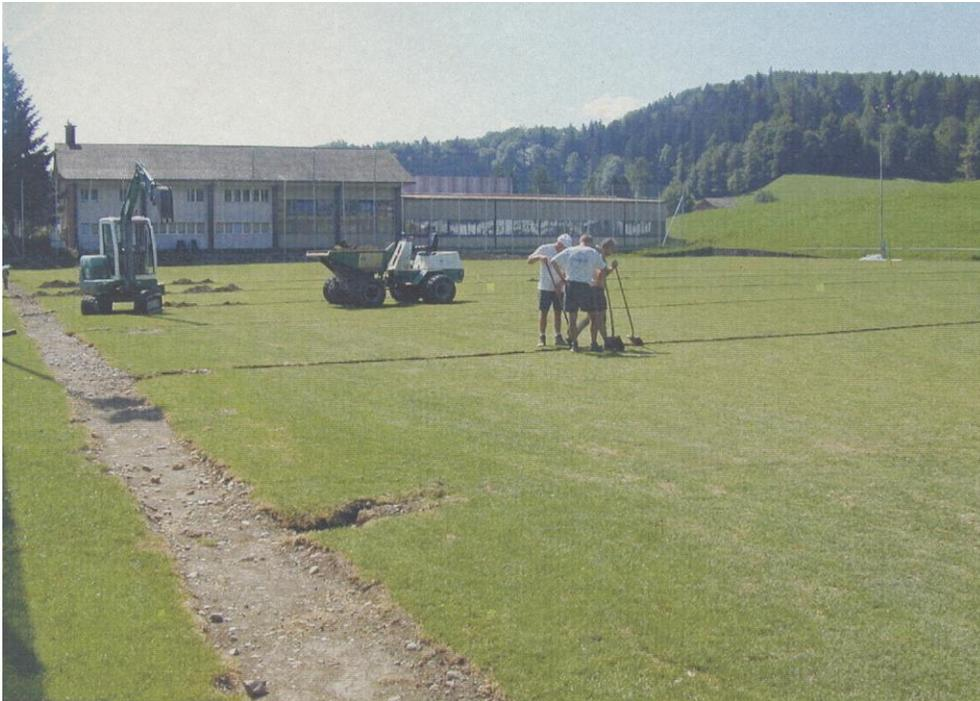
Foto: Neue Drainage; Arbeiten am Fussball-Trainingsplatz durch die Firma Göldi AG
