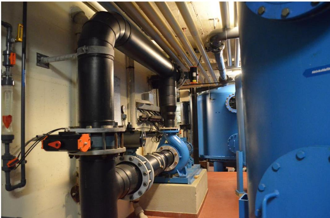
*Die komplette Wasseraufbereitungsanlage für das Schwimmbecken und das Sprudelbad ist sanierungsbedürftig. Das Reinigungsverfahren mit Sandfilter kann beibehalten werden.*
