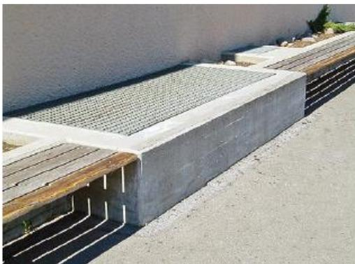
Abbildung 6: Beispiel eines erhöhten Lüftungsschachtes (Bild: GVZ)
